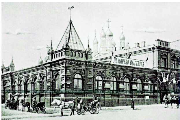
Георгиевскую электростанцию, построенную в 1880-х годах, стилизовали под сооружение XVII века.
