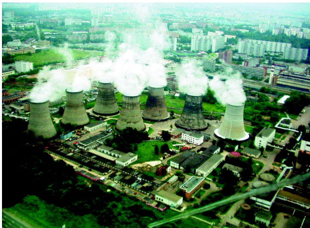
Современные ТЭЦ не только вырабатывают электроэнергию, но и обеспечивают горожан горячей водой и отоплением.
